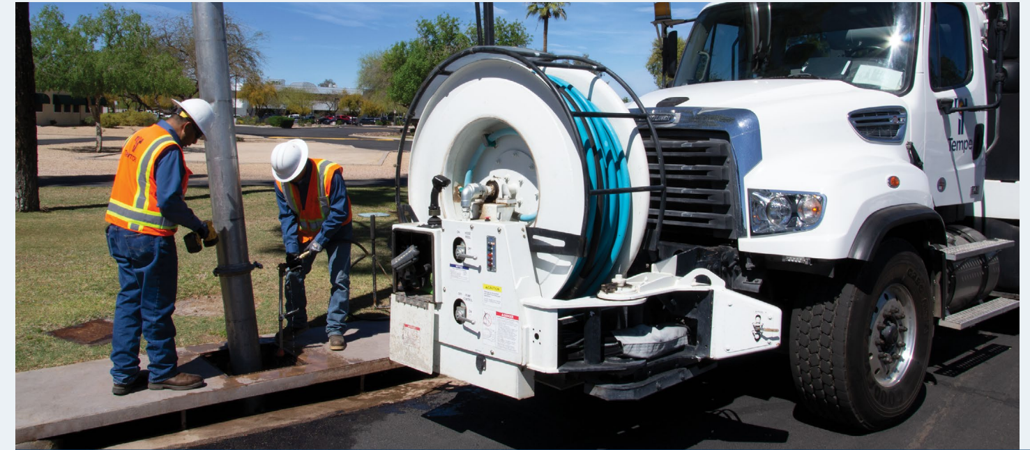
Técnicos de los servicios limpian y dan mantenimiento a la infraestructura de aguas pluviales.
